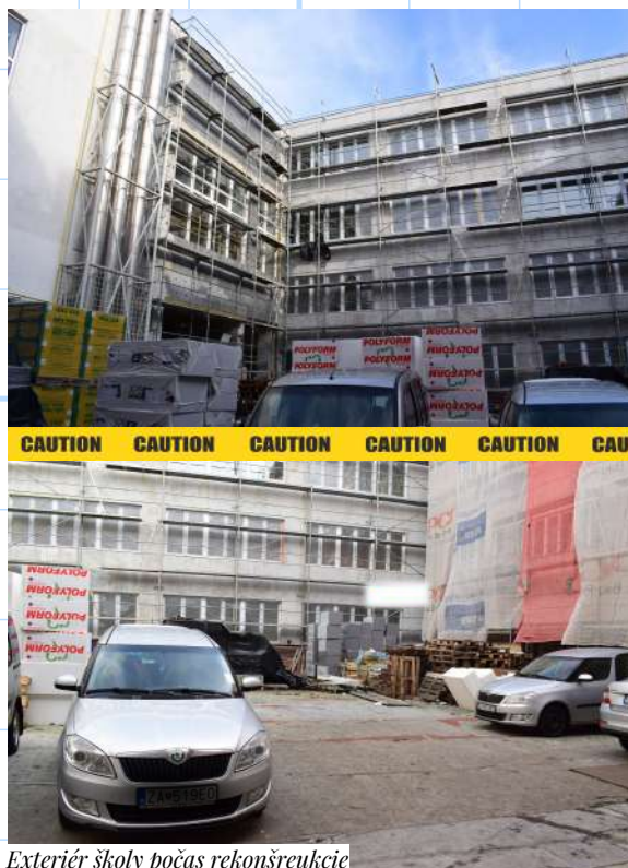
Exteriér školy počas rekonštrukcie
